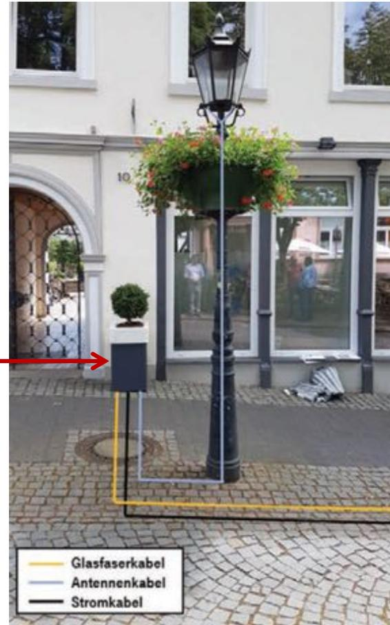
Abbildung 10: Small Cell Anbindung (schematisch)
