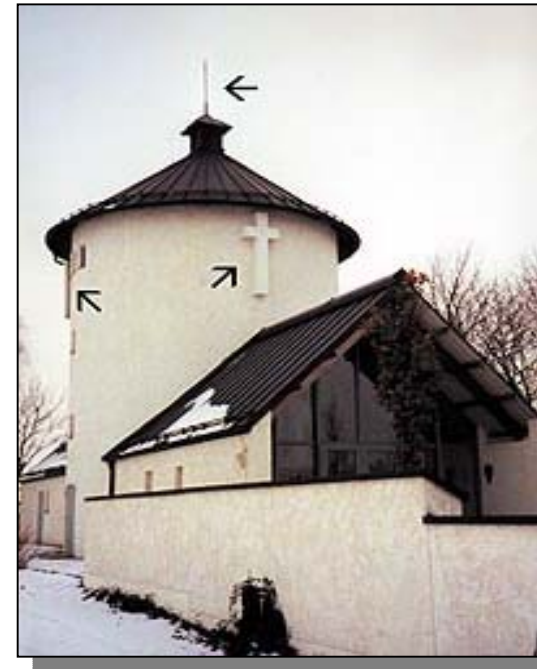
Eine hinter einem Kreuz verborgene Antenne in einem Friedhof Foto: Umweltinstitut München e.V.
